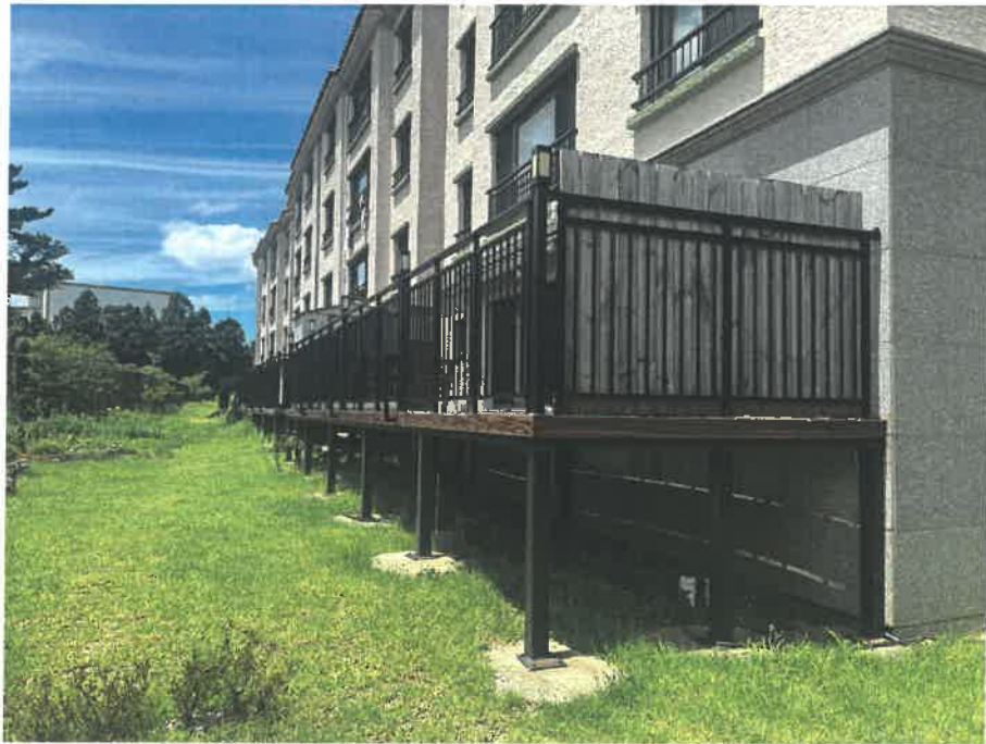
본건 1층 테라스 전경
